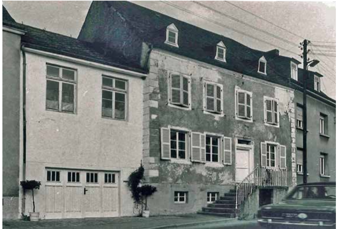
► Fassade mit aufgeputzter Eckquaderung, 1980er-Jahre Steinmetzer, Alfred, o. T., [Fotografische Aufnahme], Service des sites et monuments nationaux, Archiv SSMN, o. J.
