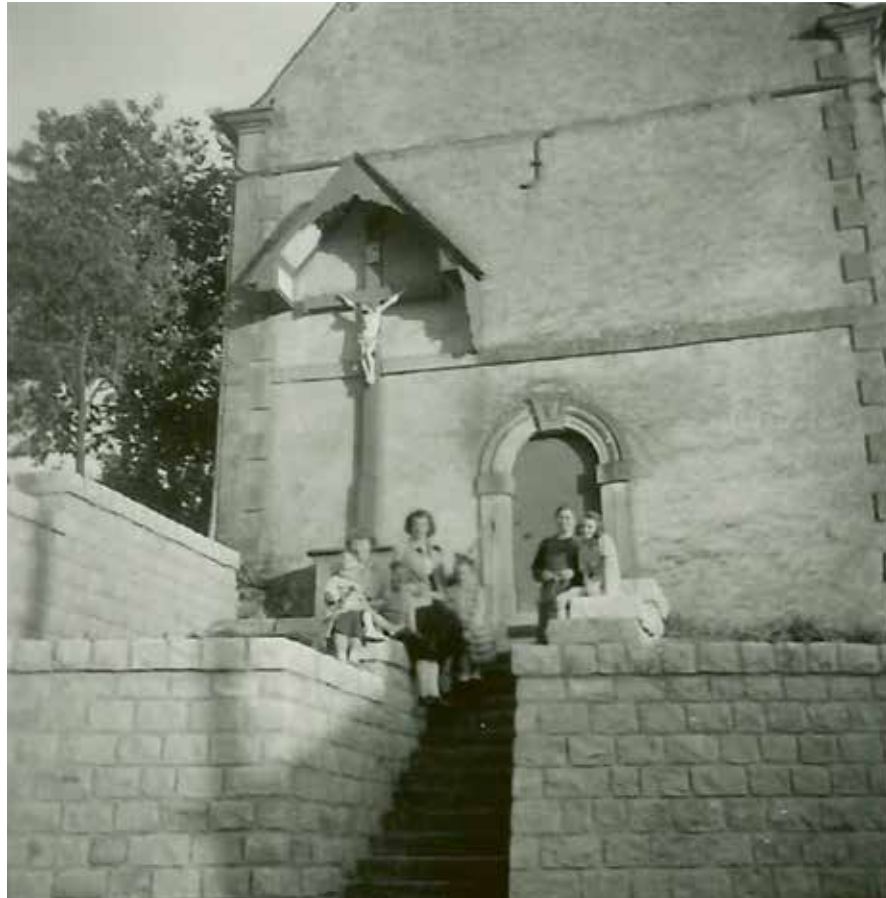
◀ Ehemaliger frontaler Treppenaufgang, der bei der Straßenerweiterung um 1960 abgerissen wurde, 1950er-Jahre Anonym, o. T., [Fotografische Aufnahme], Privatsammlung Berchem-Lefort, Olm, o. J.
