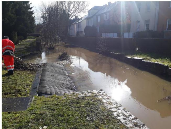
Abbildung 61: Umleitung des Osweilerbaches bei Hochwasser (AGE)
