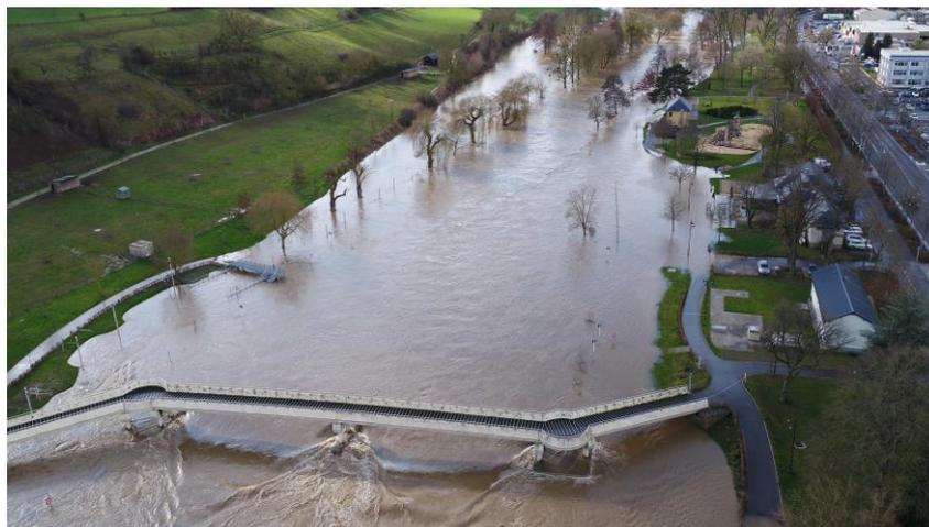
Abbildung 59: Schlauchwehr in Diekirch bei Hochwasser
