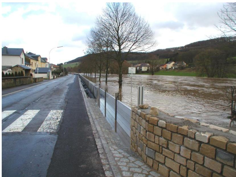
Abbildung 55: Hochwasserschutzmauer in Ingeldorf (AGE)
