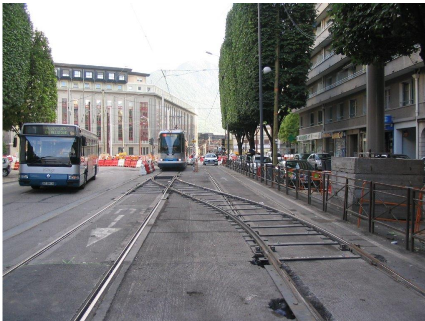
Figure 6 : Exemple d'un aiguillage californien réalisé sur le réseau tramway de Grenoble, source : Groupement 2025
