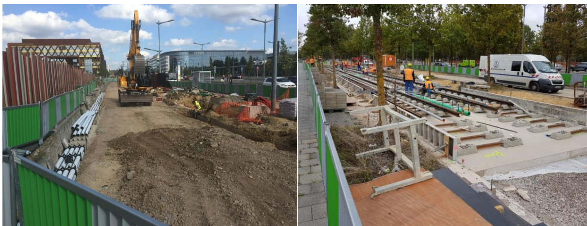
Figure 26 : Illustration des mesures de génie civil et de la pose des rails au Boulevard de la Paix. J.F. Kennedy, Kirchberg octobre 2016 (LUXTRAM S.A. 2017).
